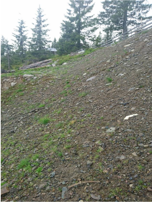
Skjæring i området – Vest.
