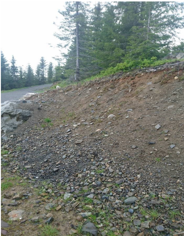
Skjæring i området – Vest.
