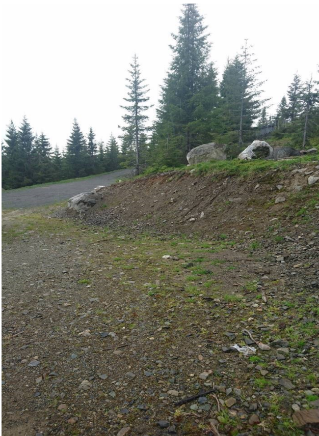
Skjæring i området – Vest.
