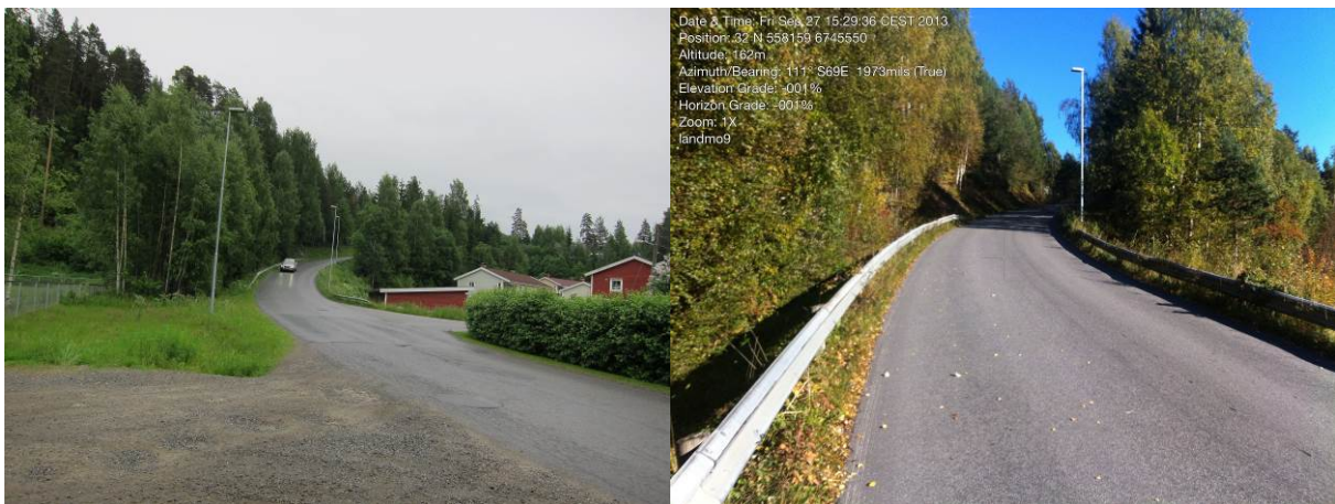
Sett fra innkjøringen til Øygardsjordet barnehage. Tosidig autovern i nedre del av bakken
